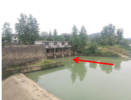
图 6 电站取水口位置
