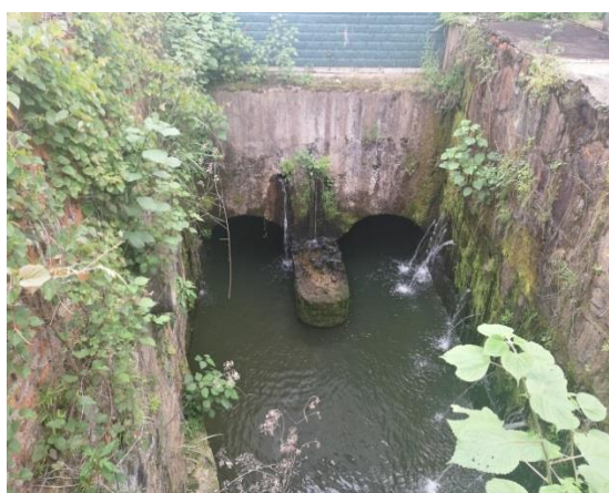
图 8 电站尾水出口
