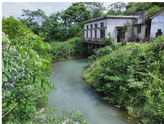
图 6 电站尾水出口
