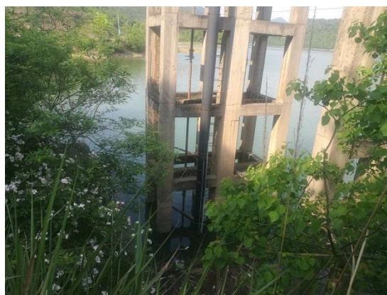
图4 电站取水口位置
