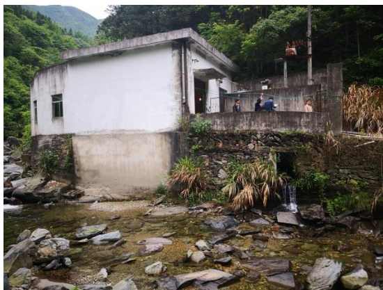
图 6 电站尾水出口
