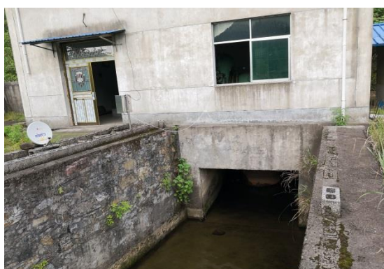
图 7 电站尾水出口
