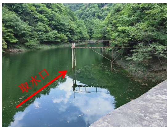
图 7 电站取水口位置
