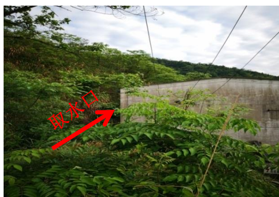
图 6 电站取水口位置
