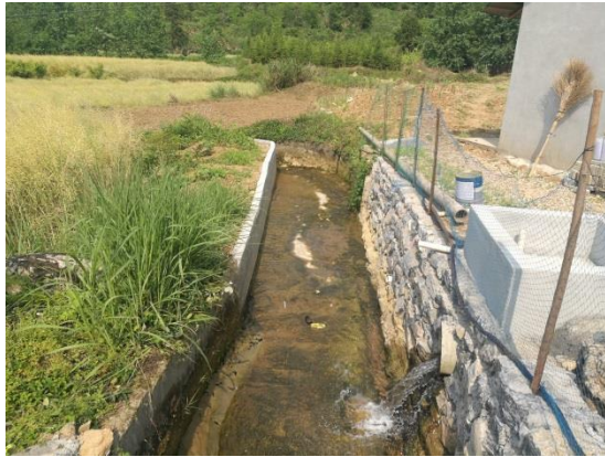
图 7 电站尾水出口
