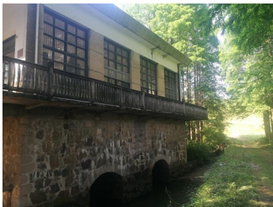
图 5 电站尾水出口
