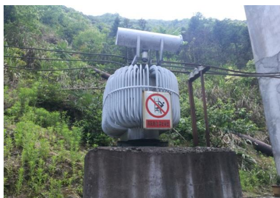
图 10 变压器
