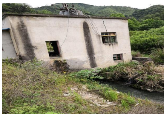
图 7 电站尾水出口
