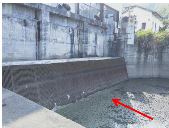
图 6 电站取水口位置
