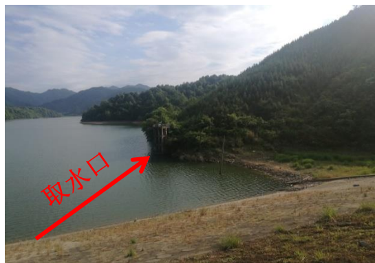
图 6 电站取水口位置
