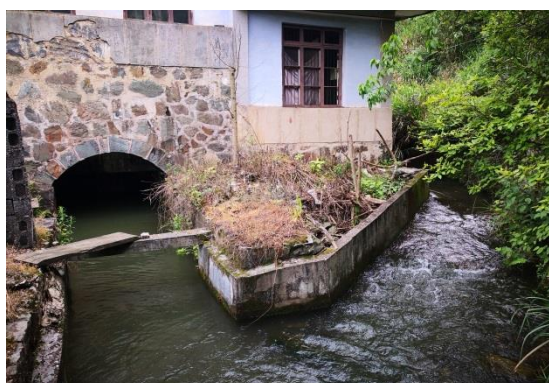
图6 电站尾水出口
