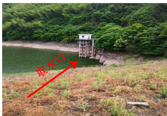
图5 电站取水口位置
