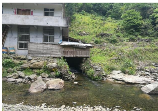
图 7 电站尾水出口
