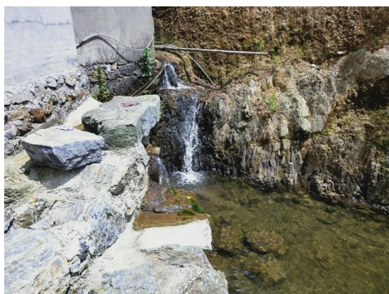
图7 电站尾水出口
