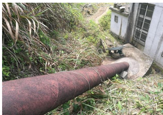
图 6 电站取水口位置
