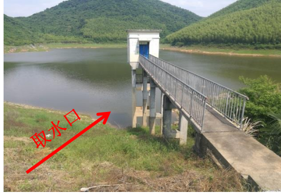
图 6 电站取水口位置
