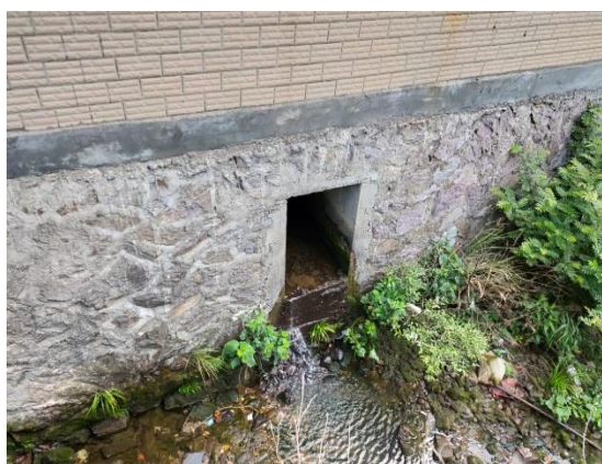
图 8 电站尾水出口
