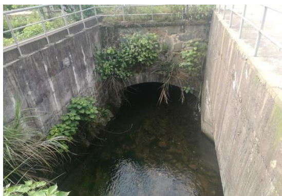
图 7 电站尾水出口
