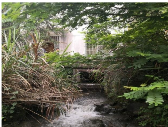
图 7 电站尾水出口
