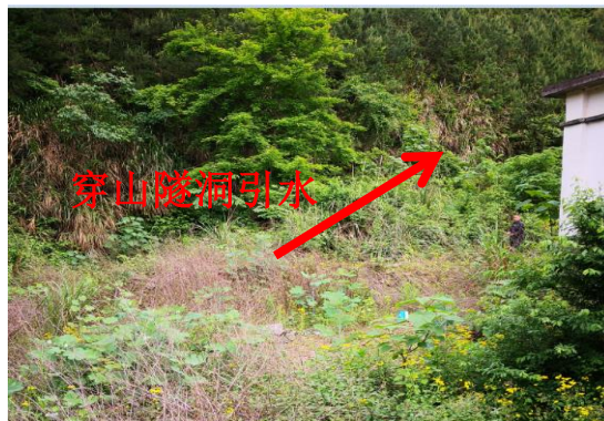
图 6 电站取水口位置
