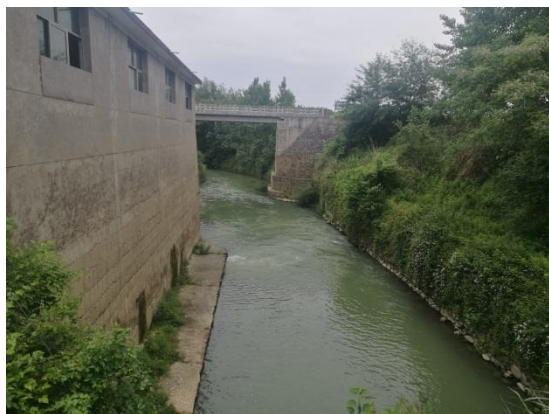
图 7 电站尾水出口
