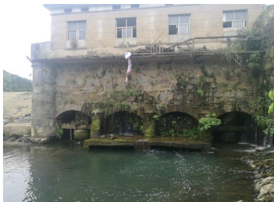
图 7 电站尾水出口
