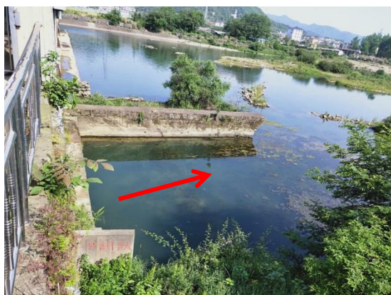
图 7 电站尾水出口
