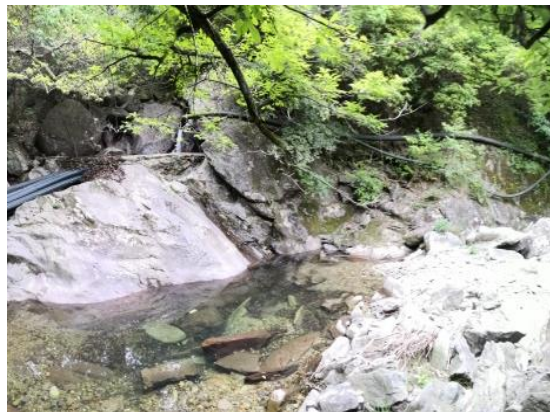
图 5 电站取水口位置
