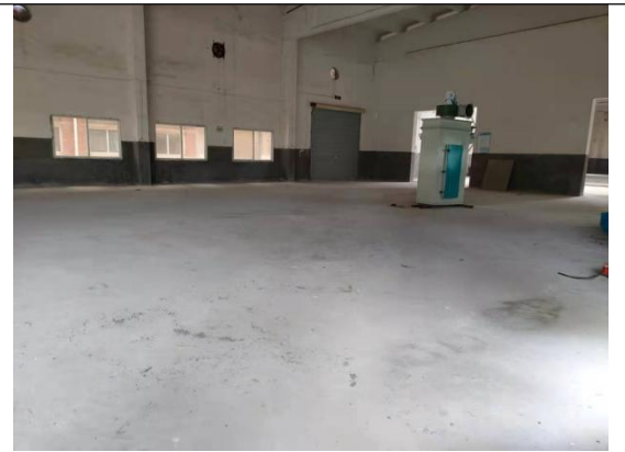
名家生物车间内现状
