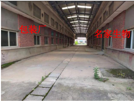
厂区中部生产厂房
